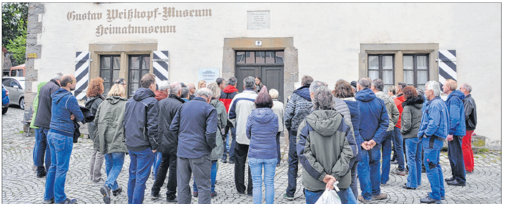
An der Fassade des Alten Landgerichts in Leutershausen – hier bei einem Tag der offenen Tür im vergangenen Jahr – müssen vor der Sanierung weitere Untersuchungen erfolgen. Archivfoto: Wolfgang Grebenhof
